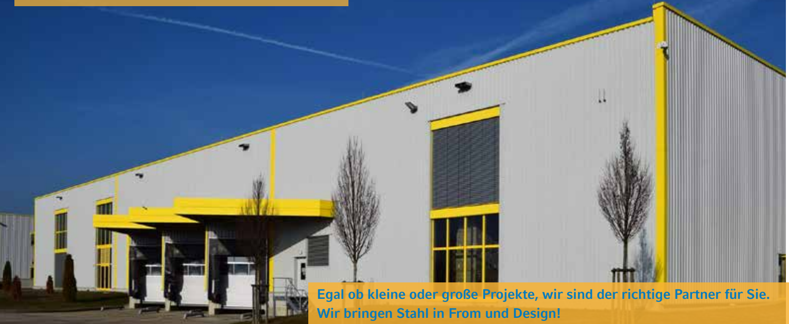
Neubau Produktionshalle: Kärcher Obersontheim
